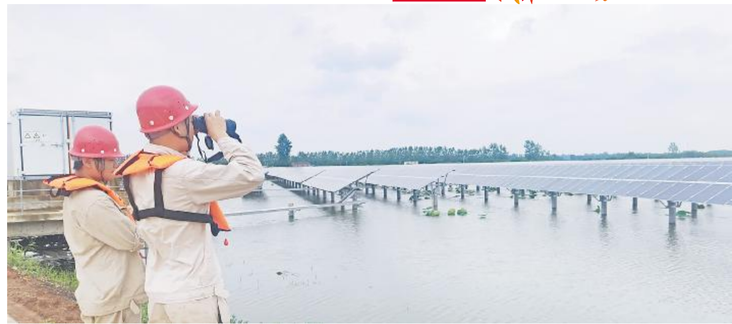
运维人员观察水位上涨和天气情况
